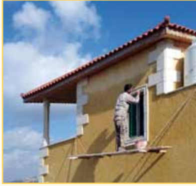
الشكل (٥-٢٣): سقالة البناء.
