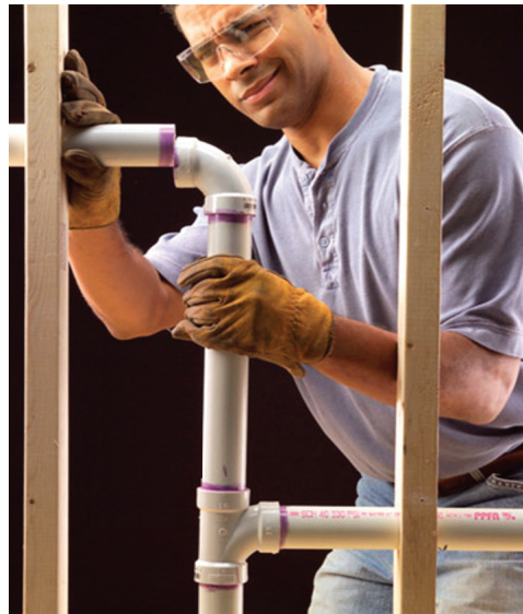
الشكل (٣-١): وصل أنابيب الصرف الصحي بالحشر والتثبيت بالغراء.
