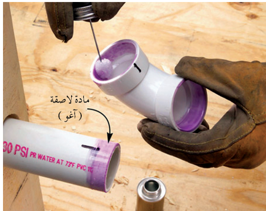
الشكل (٣-١): وصل أنابيب الصرف الصحي بالحشر والتثبيت بالغراء.
