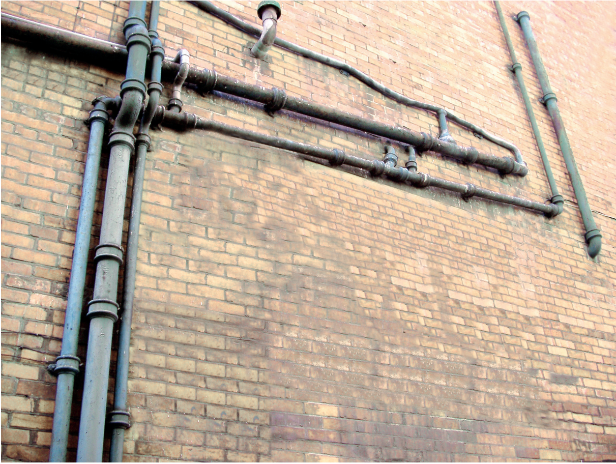
الشكل (٢-٣): شبكة تصريف صحي خارجية على جدار المبنى.
