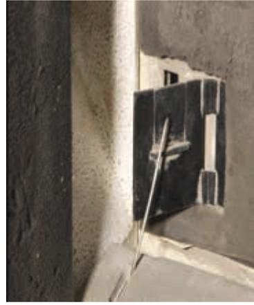
الشكل (٢-١٠): بوّابات تجديد الهواء وحركة الهواء لمكّيف النافذة.
